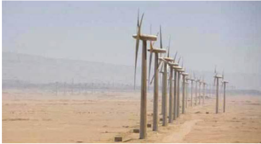
Figure 1.4 : Ferme éolienne Kebertene-Algérie [13].
