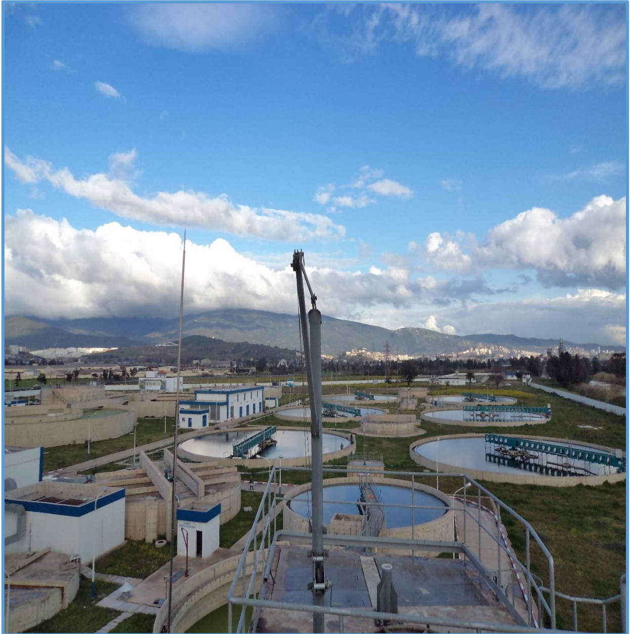
Figure 2.1 : Vue générale de la Station d'épuration de L'ALLALIK.
