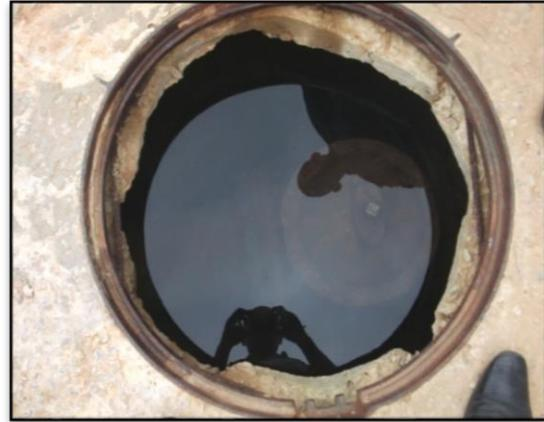
2. Des regards de sectionnement se trouvent dans un état de dégradation très avancé et sans tampons. Ces derniers nécessitent des reprises totalement.
