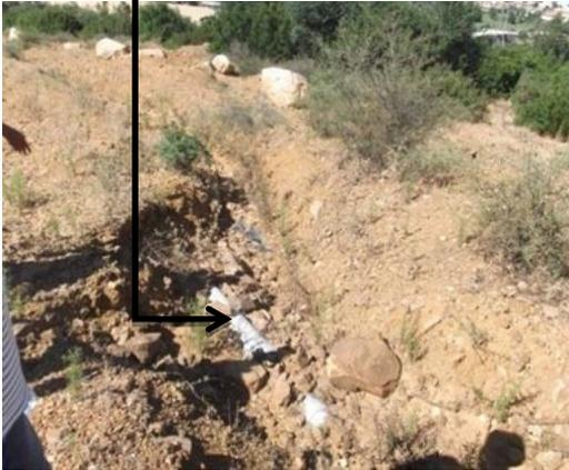
Fuite sur la conduite PVC à joint DN250 mm
