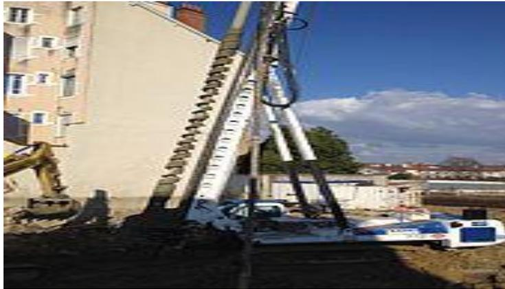
Figure 1.16 : Machine à pieux ou foreuse sur un chantier de fondation spéciale.
