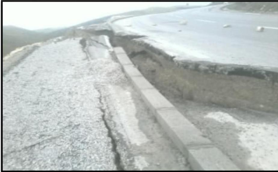
Figure.2.3 : Affaissement de la chaussée.
