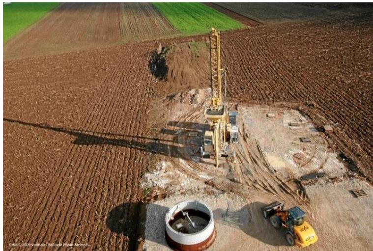
Figure 1.12 : Colonnes ballastées
