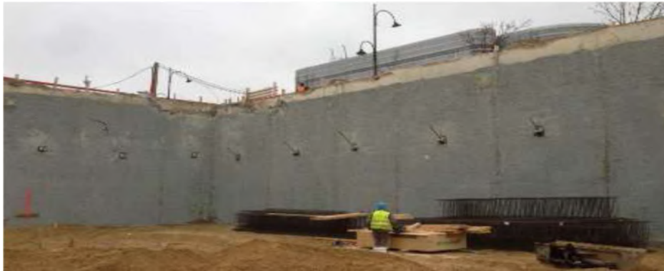
Figure 2.1. Photo du parois moulées
