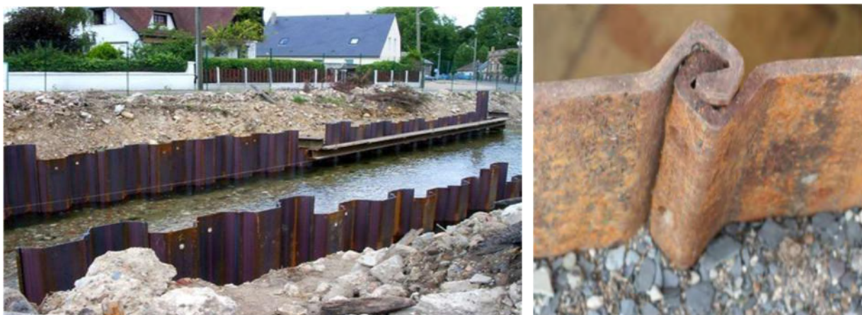
Figure 2.12. Illustration de la serrure et d'un rideau de palplanches
