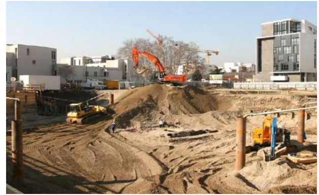
Figure 1.4 Pompage en marche
