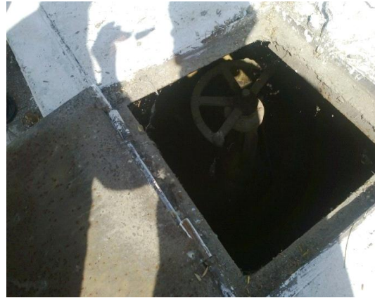
Figure IV.20 : Chambres à vannes de la SP1
