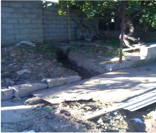
Figure IV.34 : Conduite secondaire pleine des fuites à l'intérieure d'une maison d'un citoyen.
