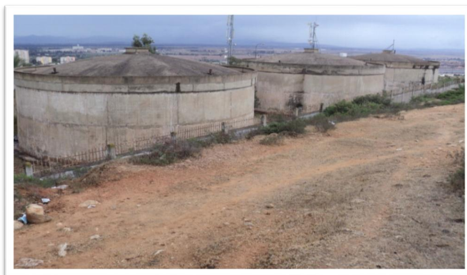
Figure III.6 : réservoir (4*1500)m 3 [5]
