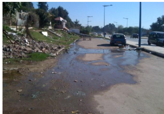
Figure IV.36 : Des fuites considérables des eaux usées et potables.
