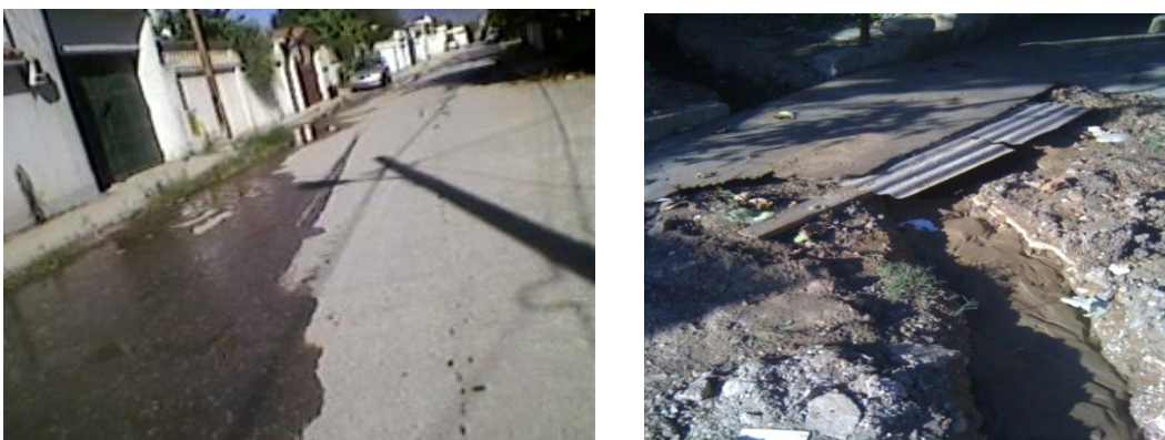
Figure IV.33 : UV 12 plein des fuites considérables.
