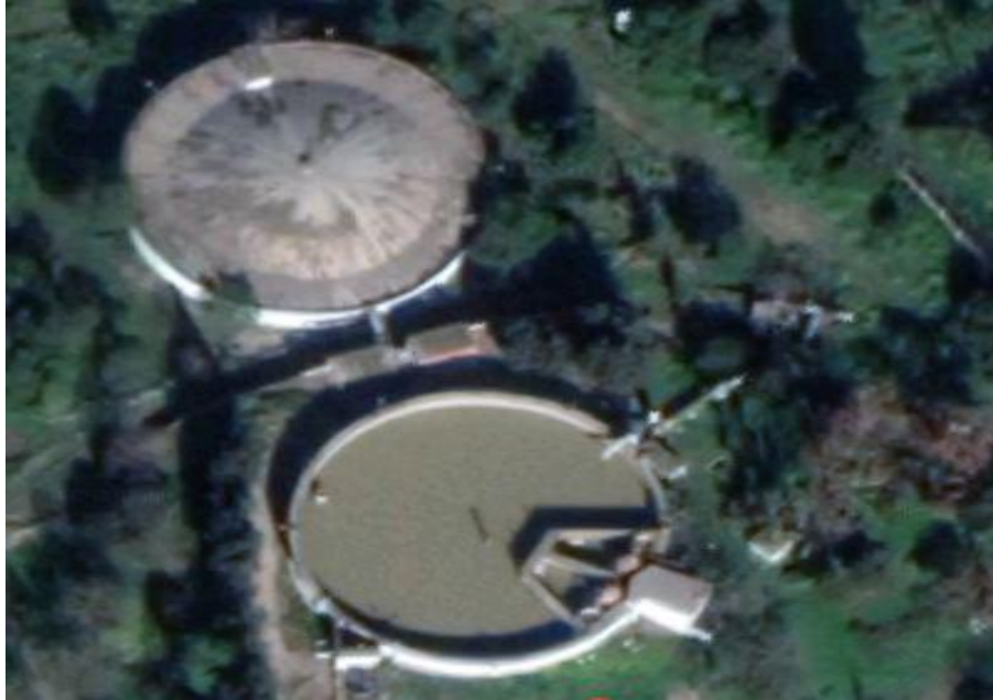
Figure III.7 : (photo Google Earth) réservoir 5000 m 3 situé à l'intérieur de station
