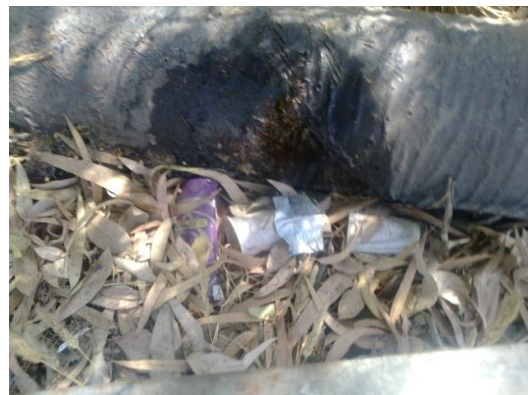
Figure IV.21 : Conduite posée sur terre au niveau de la clôture de l'université
