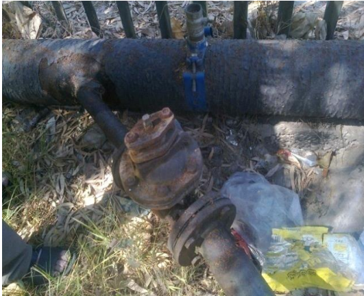
Figure IV.21 : Conduite posée sur terre au niveau de la clôture de l'université
