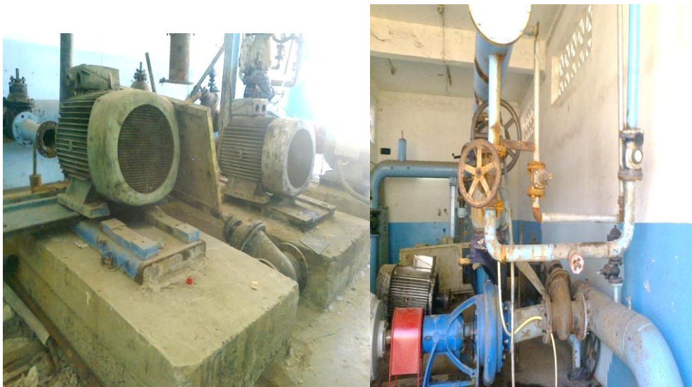
Figure IV.9 : Les groupes électropompes.
