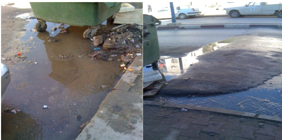
Figure IV.28 : Conduites de distribution en acier fuis.
