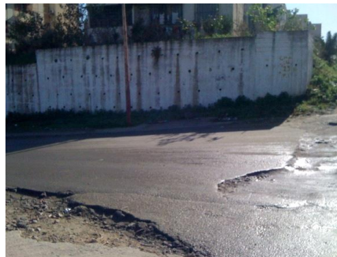
Figure IV.26 : Fuite dans la conduite des eaux usées au voisinage des conduites d'eaux potables.
