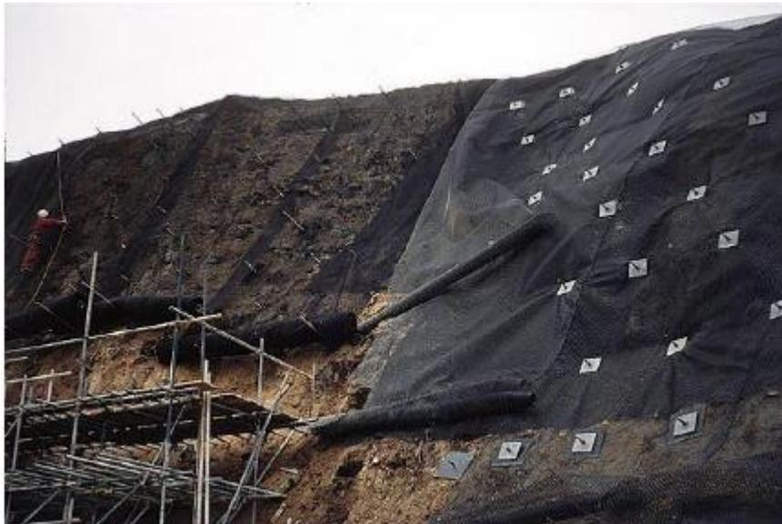
**Figure 1.19 : Un versant stabilisé par clouage.**
