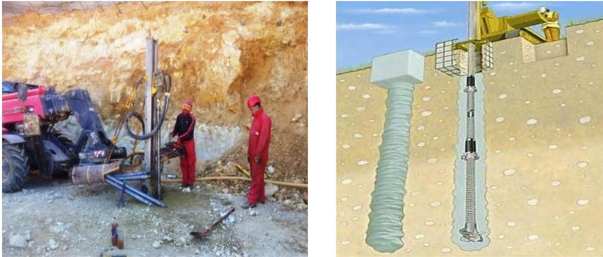
**Figure 1.21. Installation de micropieux**
