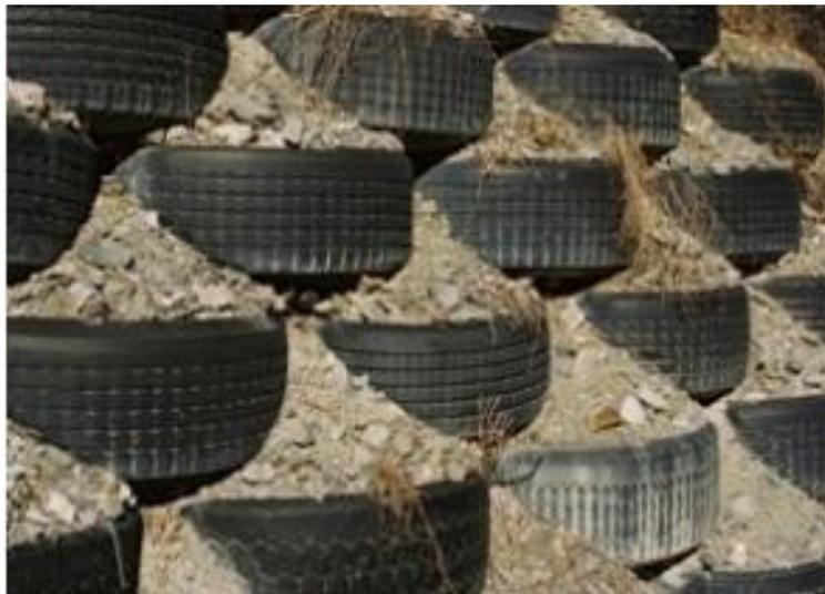
**Figure 1.23 : Renforcement par Pneusol**
