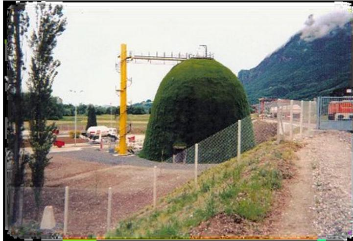
Il est utilisé dans les travaux d'élargissement de plates-formes routières ou ferroviaires ou dans les ouvrages de soutènement.
