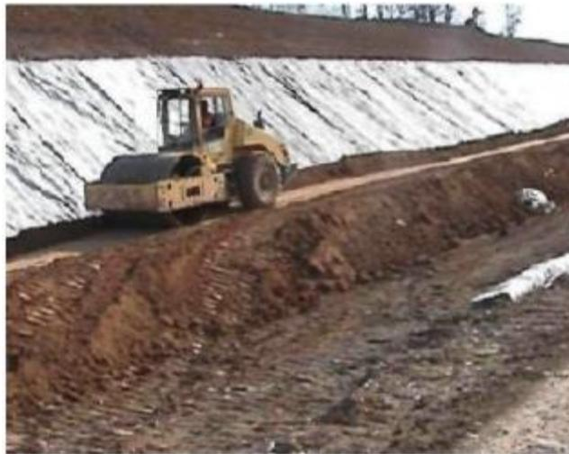
**Figure 1.20 : L'utilisation du géotextile en jouant un double rôle le drainage et le renforcement du talus.**
