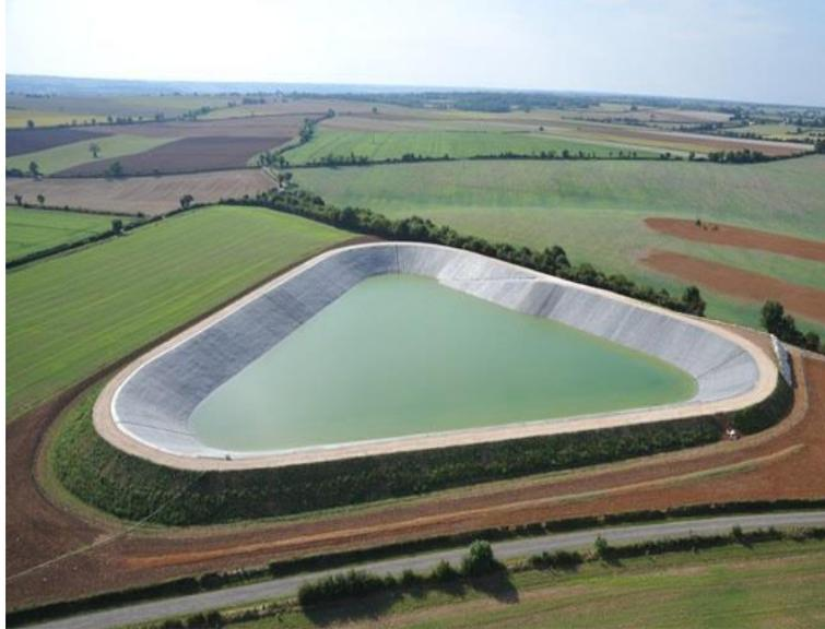
**Figure 1.24 Bassin de rétention renforcée par géomembranes**
