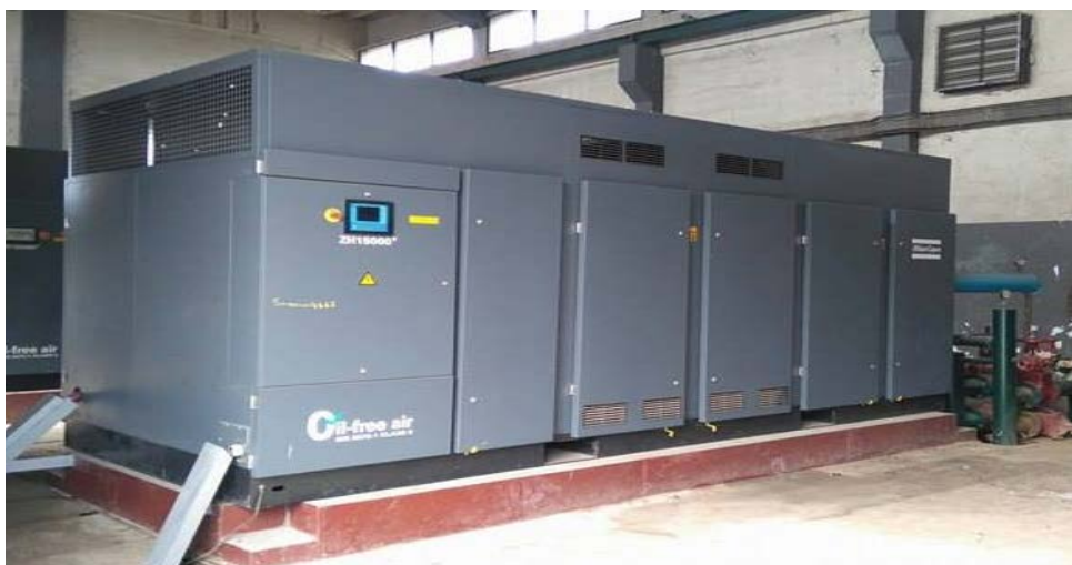
Figure I.16: Compresseur copo atlas à troisétages.
