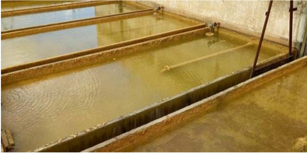
Figure I.10 : Filtre à sable.
