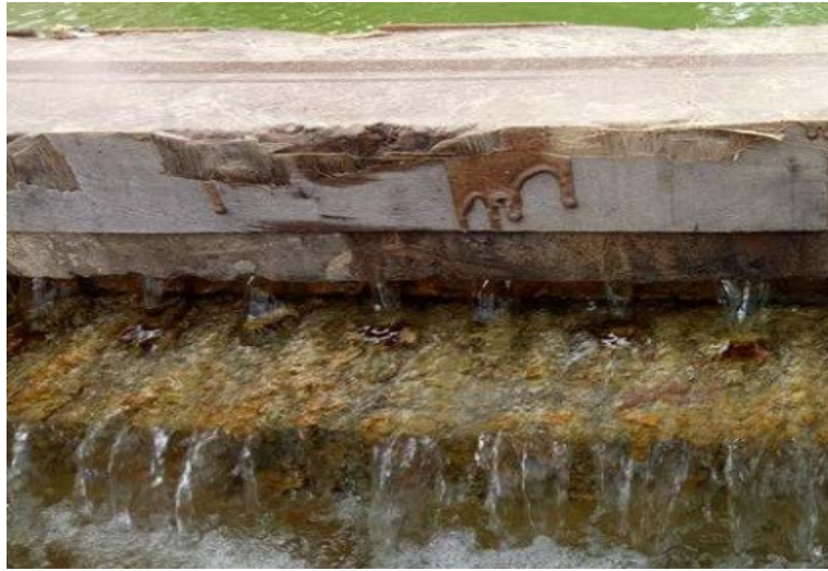
Figure I.9: Eau débordante du décanteur.
