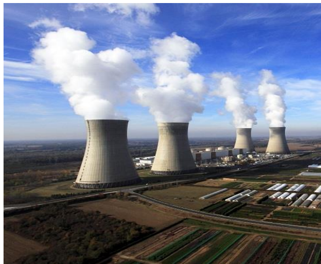
Figure (I-3) : Centrale thermique nucléaire
