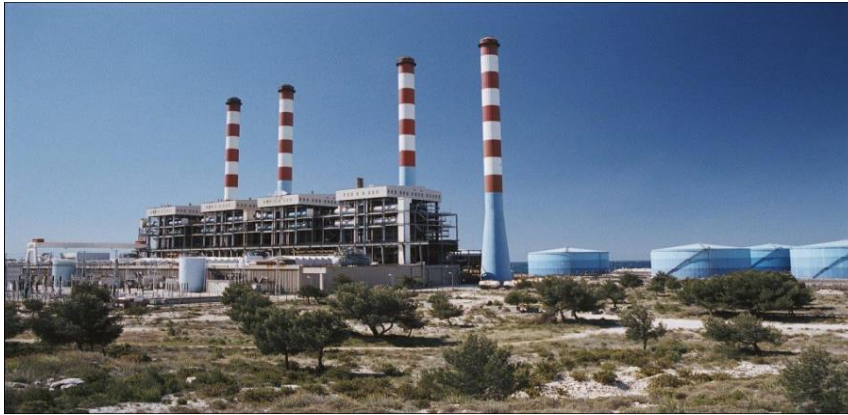
Figure (I-2) : Centrale thermique à flamme
