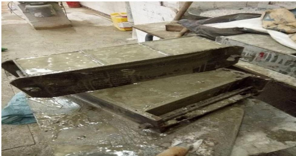
Figure III. 15- la mise en place de béton dans les moules
