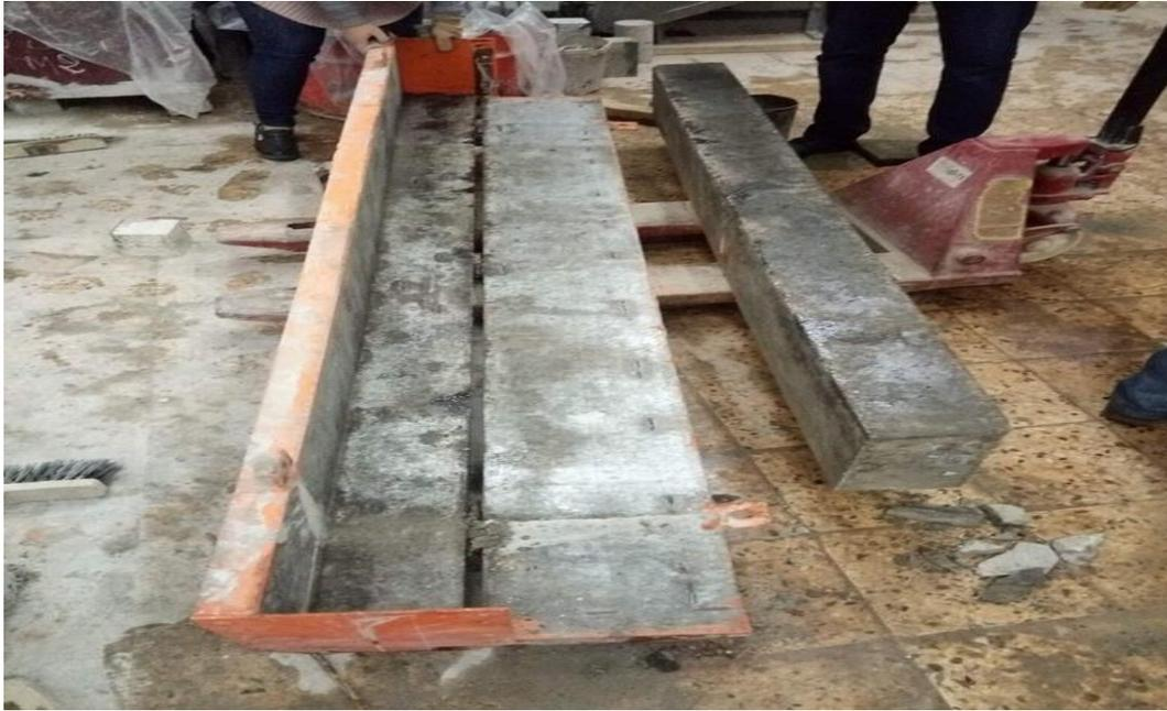
Figure III. 16- démoulage des poutres
