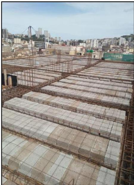
Figure 7-4 : Ferrailage et coffrage du plancher
