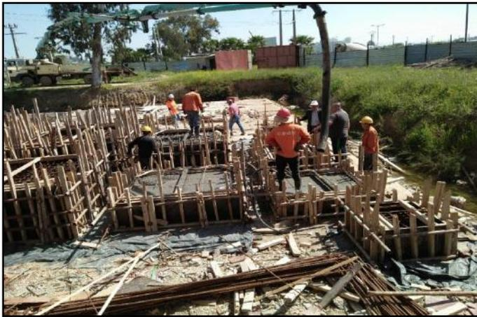
Figure 7-21 : La fabrication des regards sur chantier
