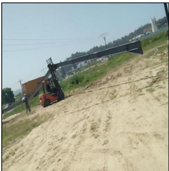
Figure 7-13 : Déplacement des fermes avec un chariot élévateur
