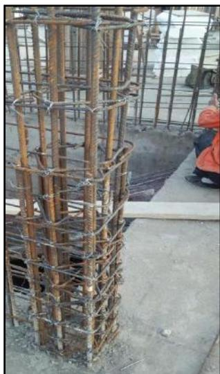
Figure 7-7 : Ferrailage du poteau
