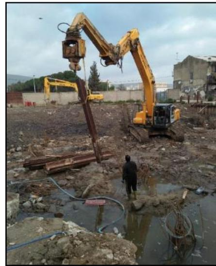
Figure 5-19: la mise en place des palplanches
