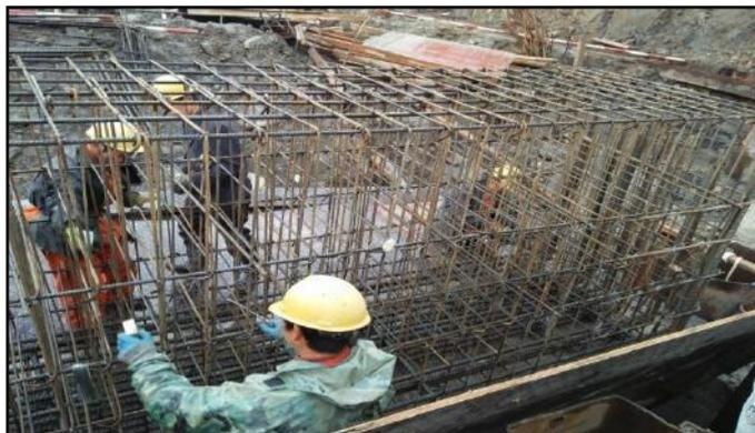
*La mise en place du béton dans les éléments de grande hauteur (notre semelle de 1.5m d'hauteur).il convient de prendre une certaine précaution :*
