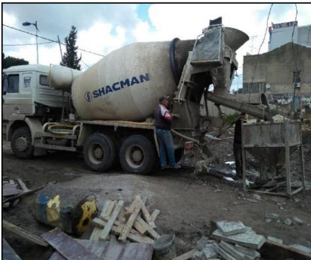
Figure 5-42 : Mise de place du béton par benne
