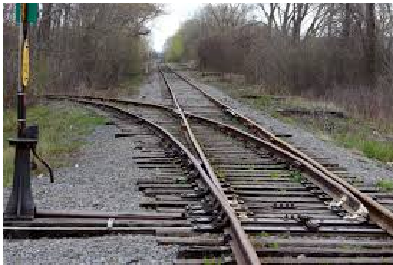
FIGURE 2.3. Appareil de voie
