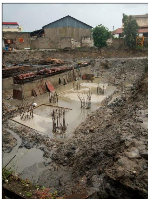
-Figure 5-37 : La mise en place de béton de propreté -
