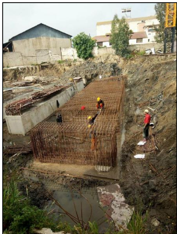
-Figure 5-38 : la mise en place du ferraillage-
