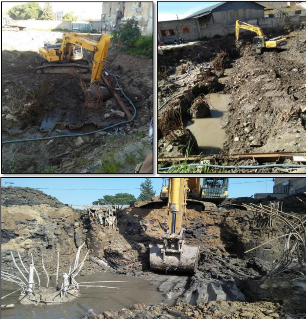
-Figure 5-25 : L'excavation du terrain-
