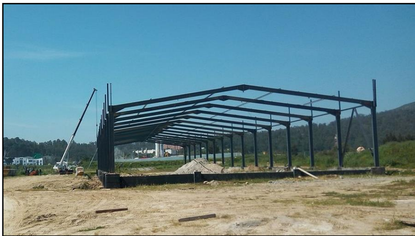
-Figure 7-11 : Vue d'ensemble du Show-room_KIV-
