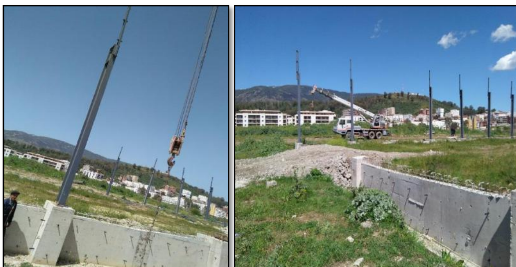
-Figure 7-12 : Les poteaux en IPE 400-
