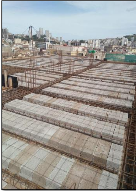
Figure 7-4 : Ferrailage et coffrage du plancher
