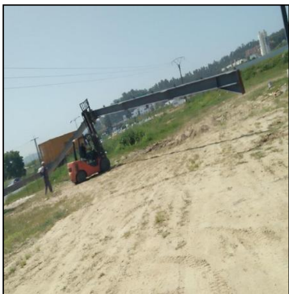
Figure 7-13 : Déplacement des fermes avec un chariot élévateur
