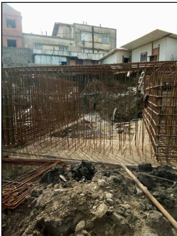
-Figure 5-38 : la mise en place du ferraillage-
