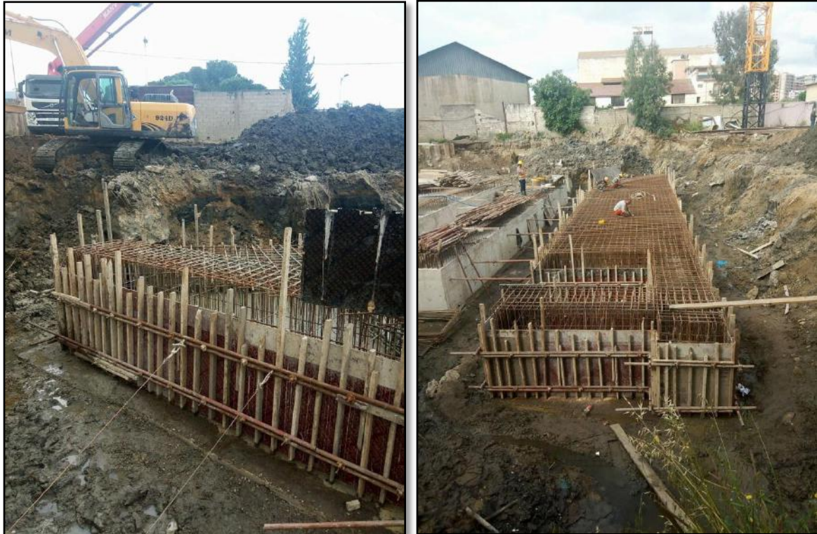
-Figure 5-41 : Le coffrage du semelle-
