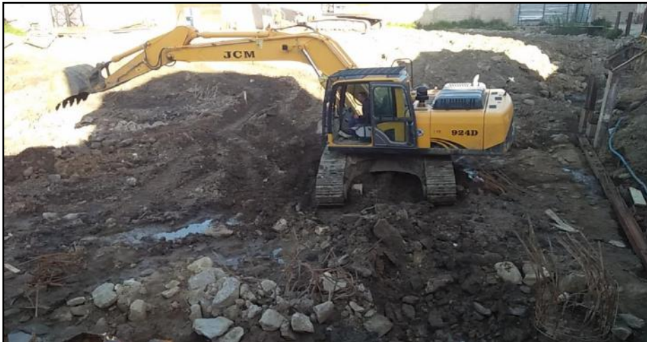
-Figure 5-24 : Matériel des travaux du terrassement-
