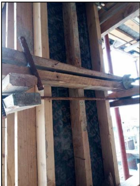
-Figure 7-1 : Coffrage du poteau-
