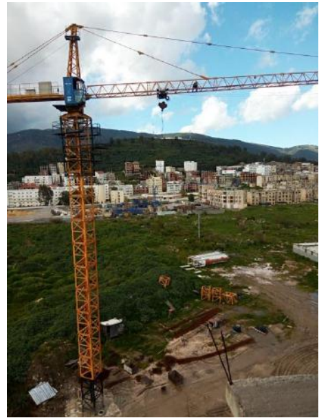
-Figure 3-4: la grue-
