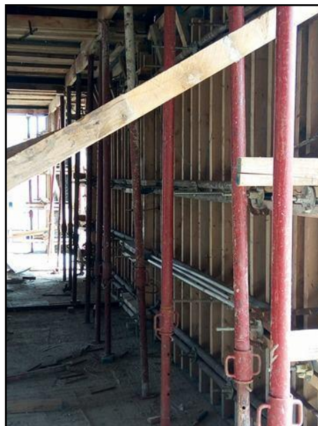
-Figure 7-2 : Coffrage du voile-
