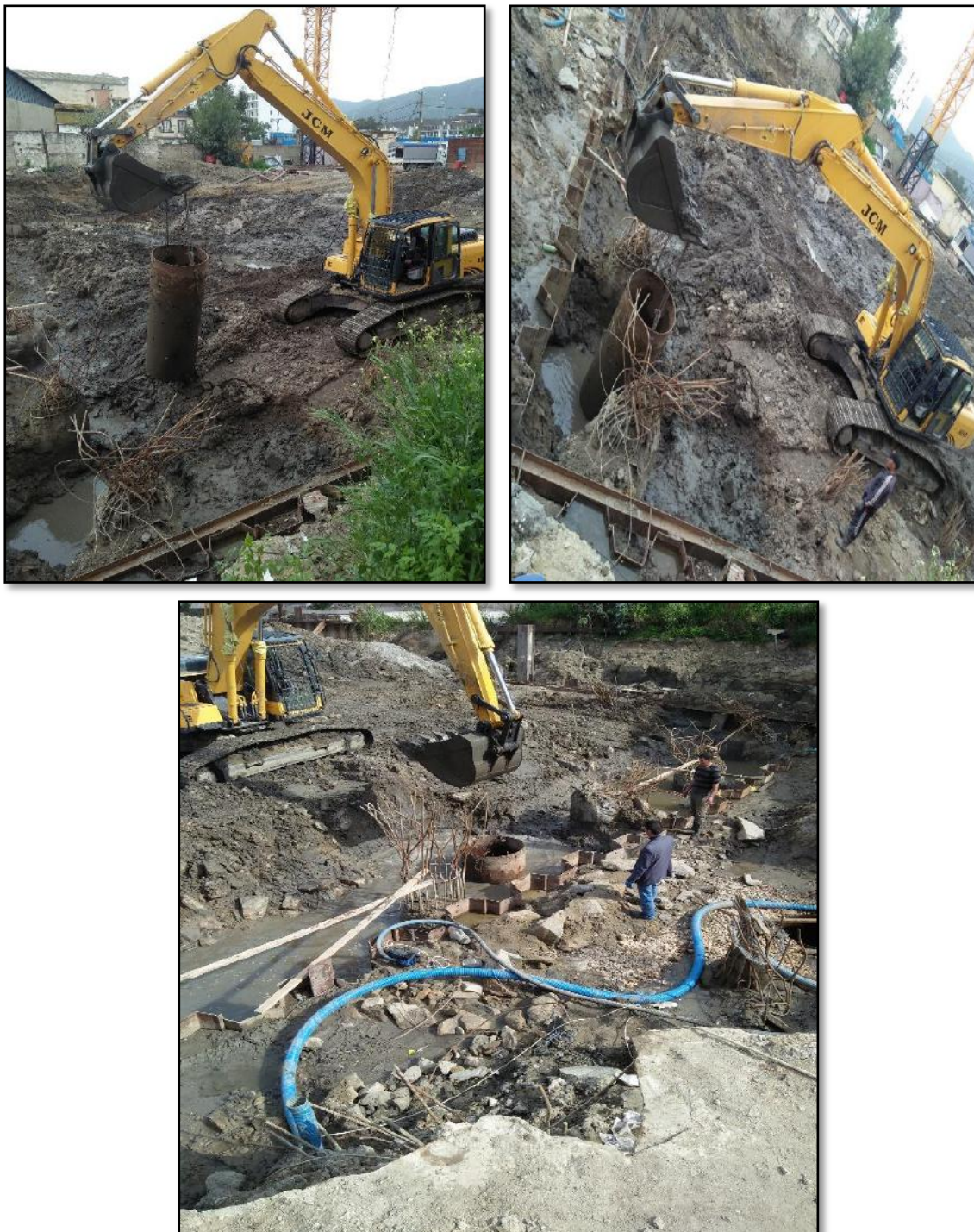
-Figure 5-28 : La mise en place des puits métalliques-
