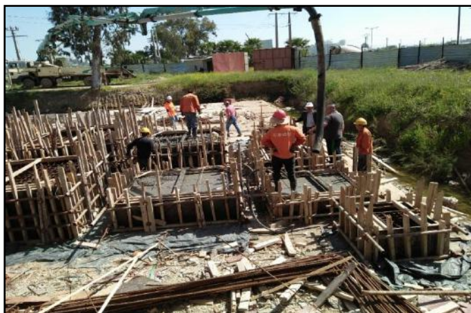
Figure 7-21 : La fabrication des regards sur chantier
