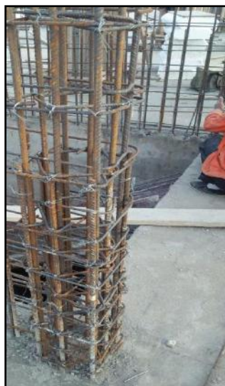
Figure 7-7 : Ferrailage du poteau
