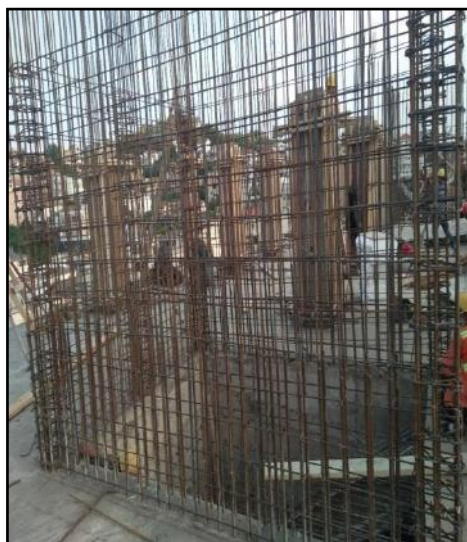
-Figure 7-8 : Ferrailage du voile-
