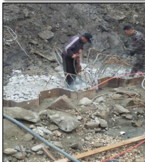
Figure 5-29 : Recépage des pieux par marteau piqueur
