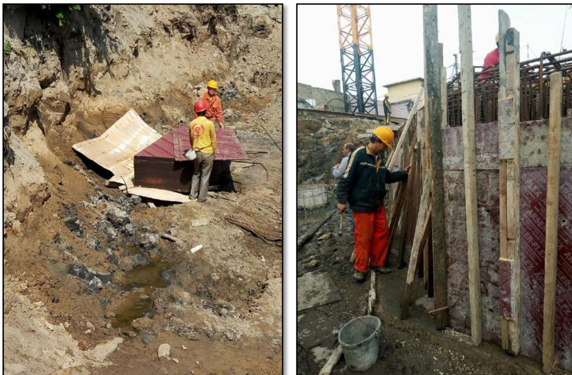
-Figure 5-40 : les panneaux de coffrages-
