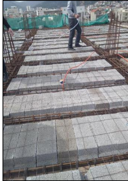
Figure 7-5 : Installation des gaines d'électricité
