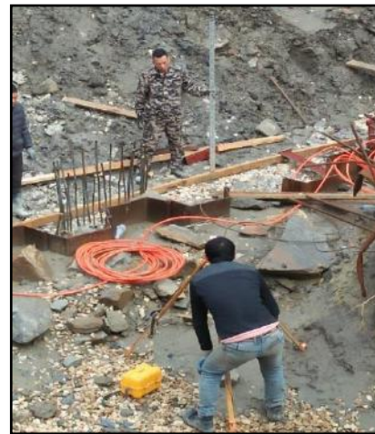
-Figure 5-35 : Nivellement béton propreté par Théodolite-
