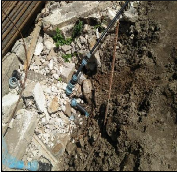
-Figure 3-5: Branchement d'eau-
