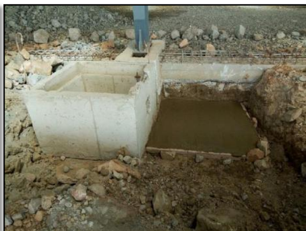
Figure 7-22 : Mélange de gravillon et de sable en fond du trou
