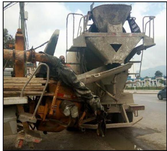
Figure 5-43 : Mise en place du béton par pompage
