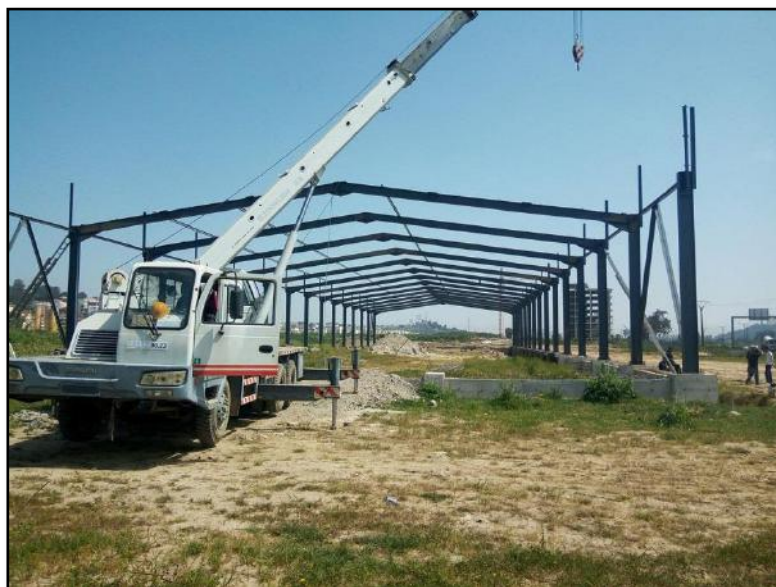
Figure 7-14 : Le montage des fermes à l'aide d'une grue mobile
