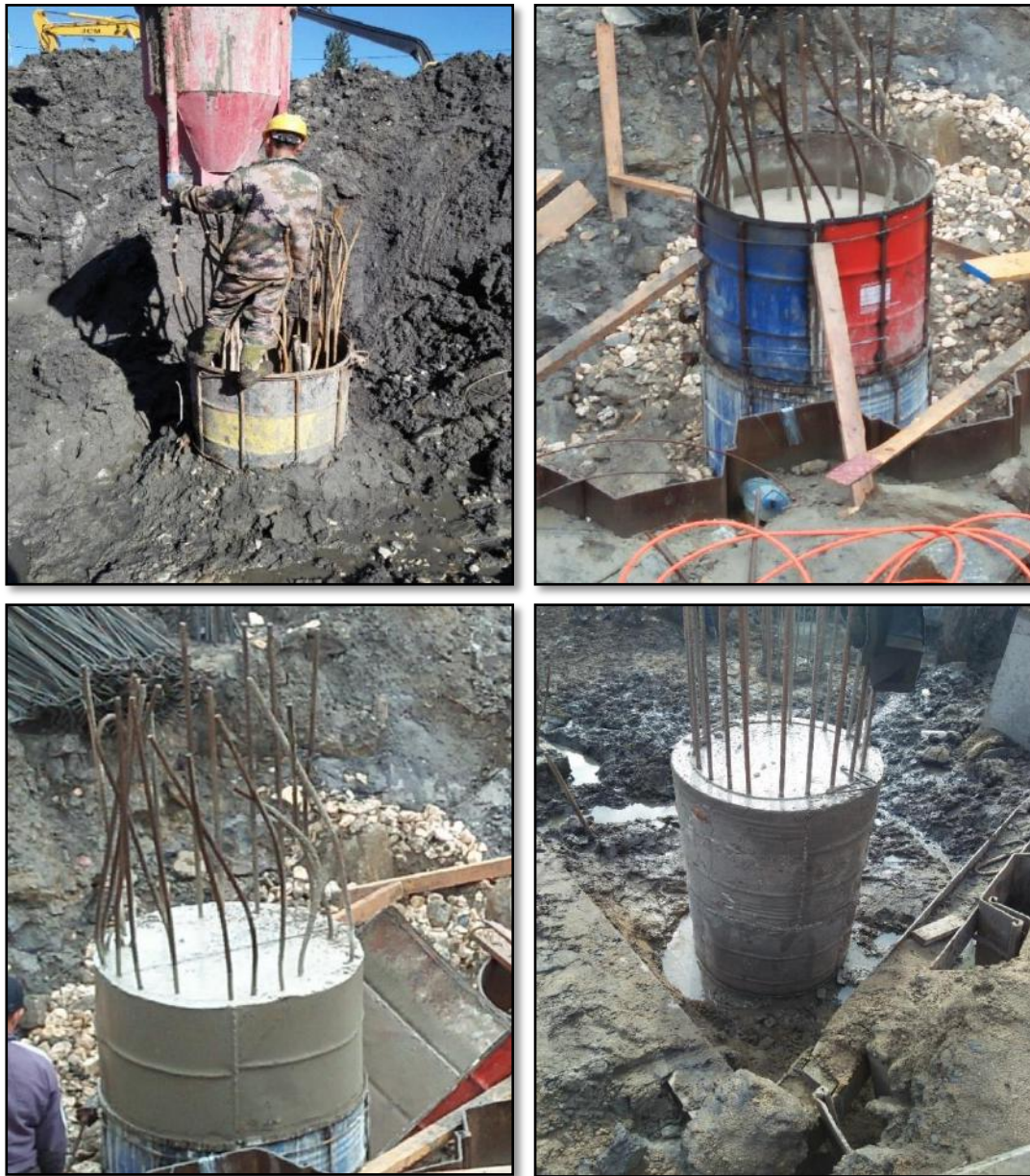
-Figure 5-34 : Le coulage et le décoffrage des pieux-
