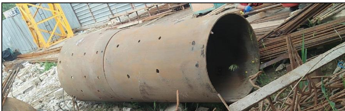
-Figure 5-27 : Puits métallique-
