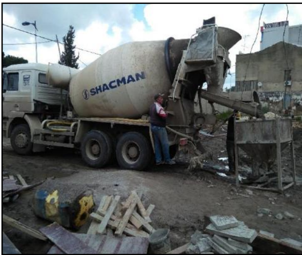
Figure 5-42 : Mise de place du béton par benne
