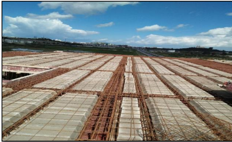
-Figure 7-9 : Coffrage et ferrailage du plancher terrasse-
