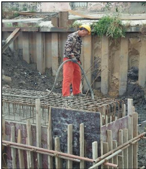
-Figure 5-46 : Vibration du béton-
