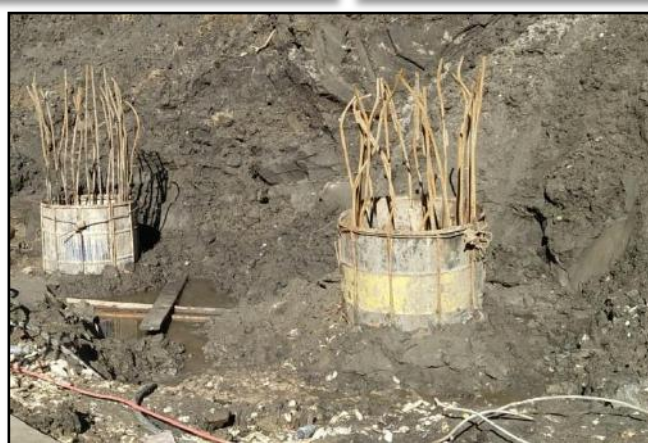
-Figure 5-33 : Le coffrage des pieux -
