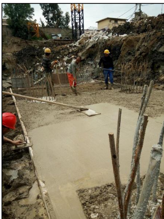
-Figure 5-37 : La mise en place de béton de propreté -
