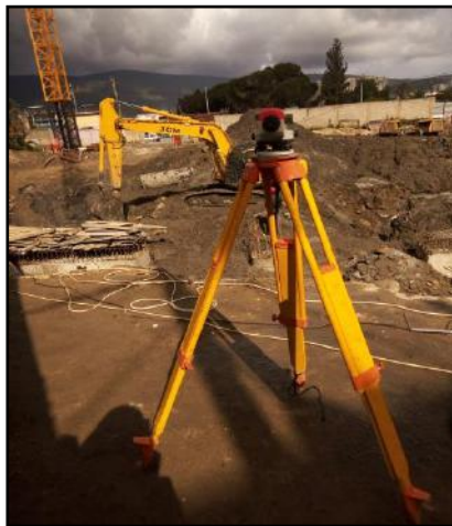
-Figure 5-35 : Nivellement béton propreté par Théodolite-
