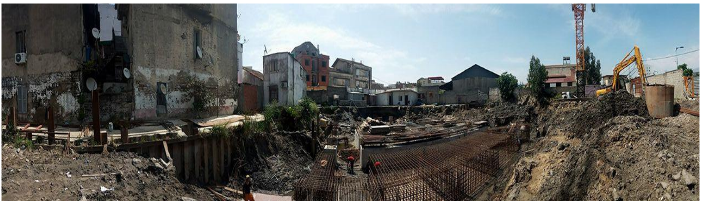
-Figure 2-2: Vue d'ensemble du chantier-
