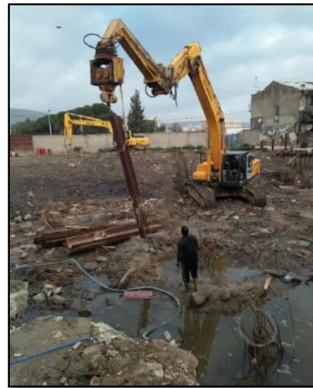
Figure 5-19: la mise en place des palplanches
