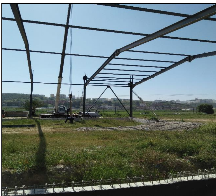
-Figure 7-15: Montage des pannes (traverses latérales)-
