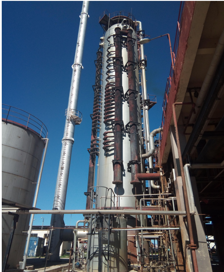
Fig. I.8.b : Colonne d'Oxydation-absorption
