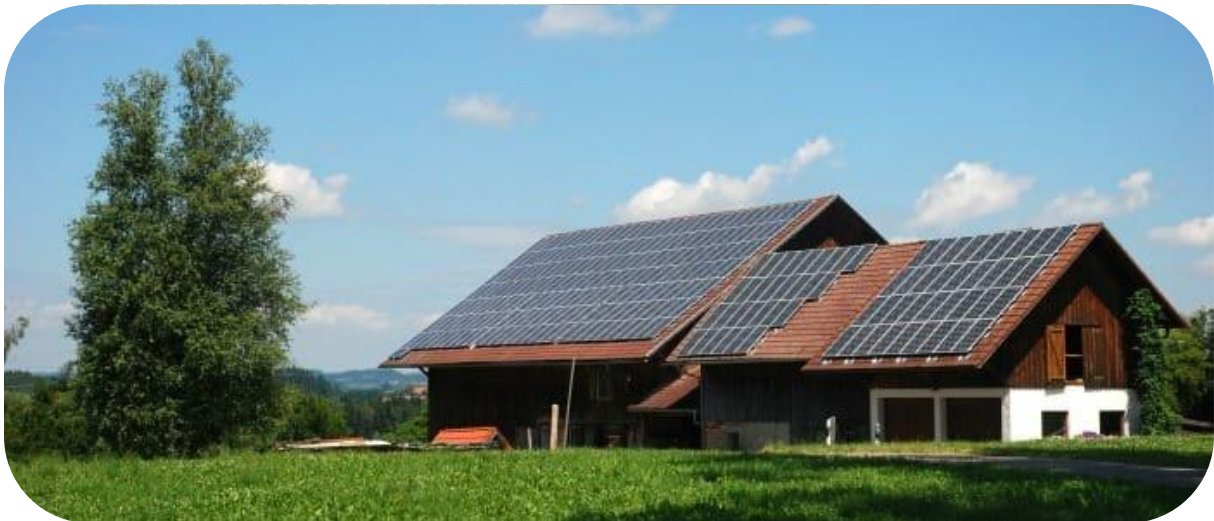
Figure II.3 : Maison avec panneau solaire
