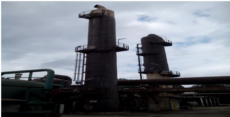
Figure I.10 : Les tours de refroidissement
