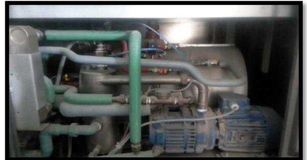
**Figure (II-23) :** chaudière d'un autoclave
