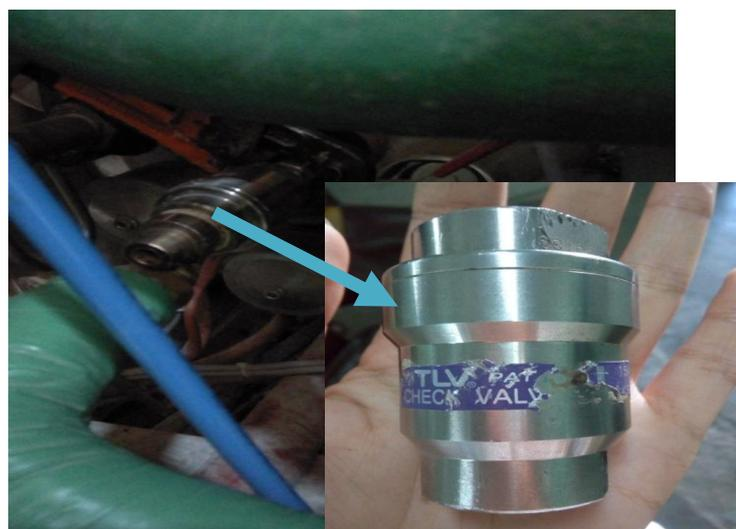
**Figure (IV-26)** : Changement de clapet
