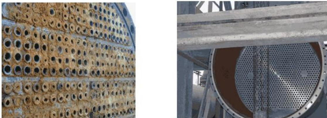
Fig. II.22 : Echangeur propre (à droite) et échangeur sale (à gauche)
