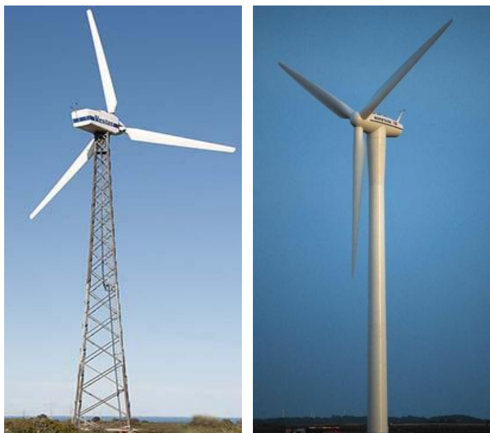
Figure I.16 : éoliennes à tour en treillis et à tour tubulaire
