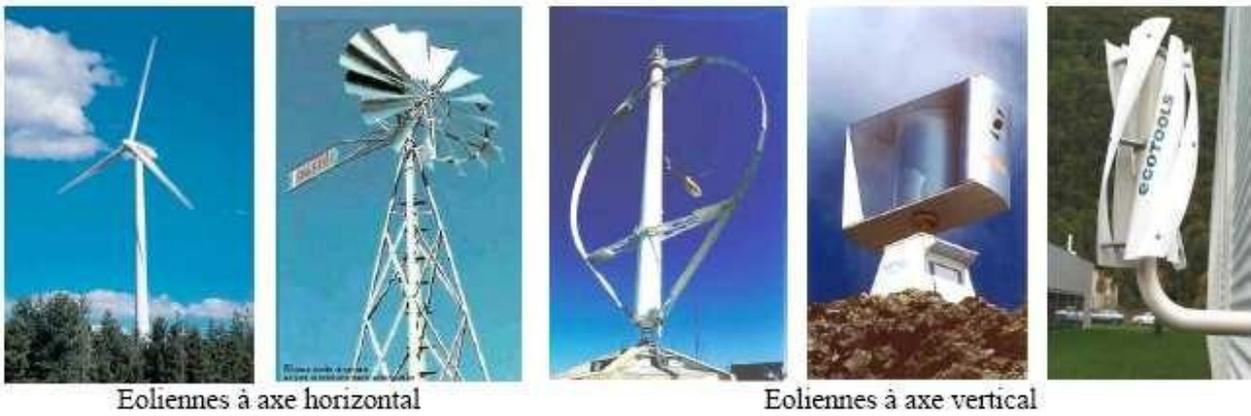
Fig 1 : Technologies d'éoliennes
