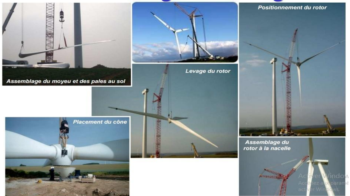
Figure. II.5 : assemblage du moyeu et des pales.
