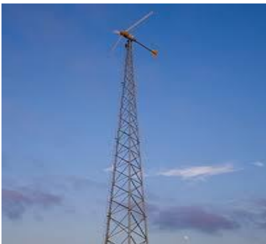
Figure. II.6 : éolienne avec mat à treillis.
