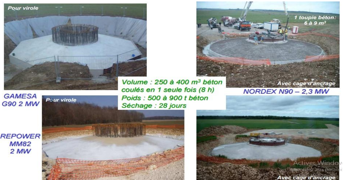
Figure. II.2 : fondation de l'éolienne .
