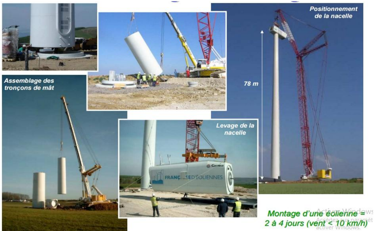
Figure. II.4 : montage du mât et de la nacelle.
