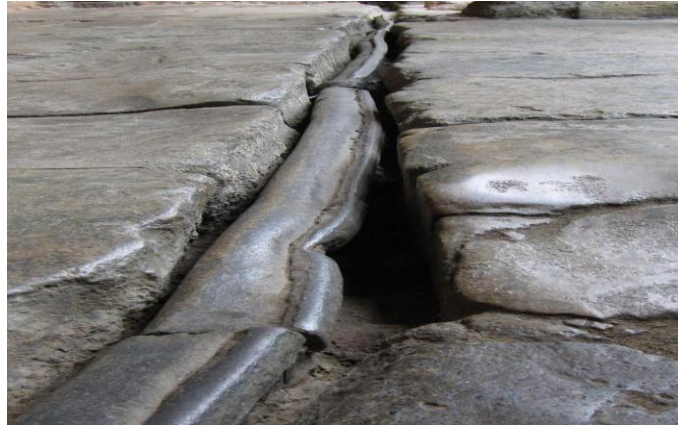
Figure I.5 Tuyaux en plomb utilisé à l'époque romaine à l'intérieur des thermes de Bath, Angleterre.
