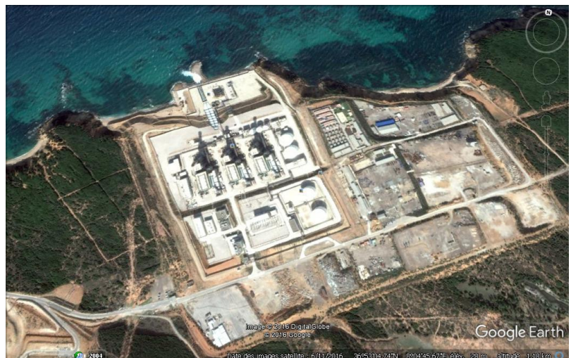
Figure I.1 : une photo prise par google earth de la central Eddraouch
