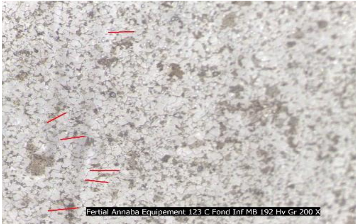
Fig2-17 :Contrôle par ressuage montre des fissures sur le fondinferieur de la calandre.[9]
