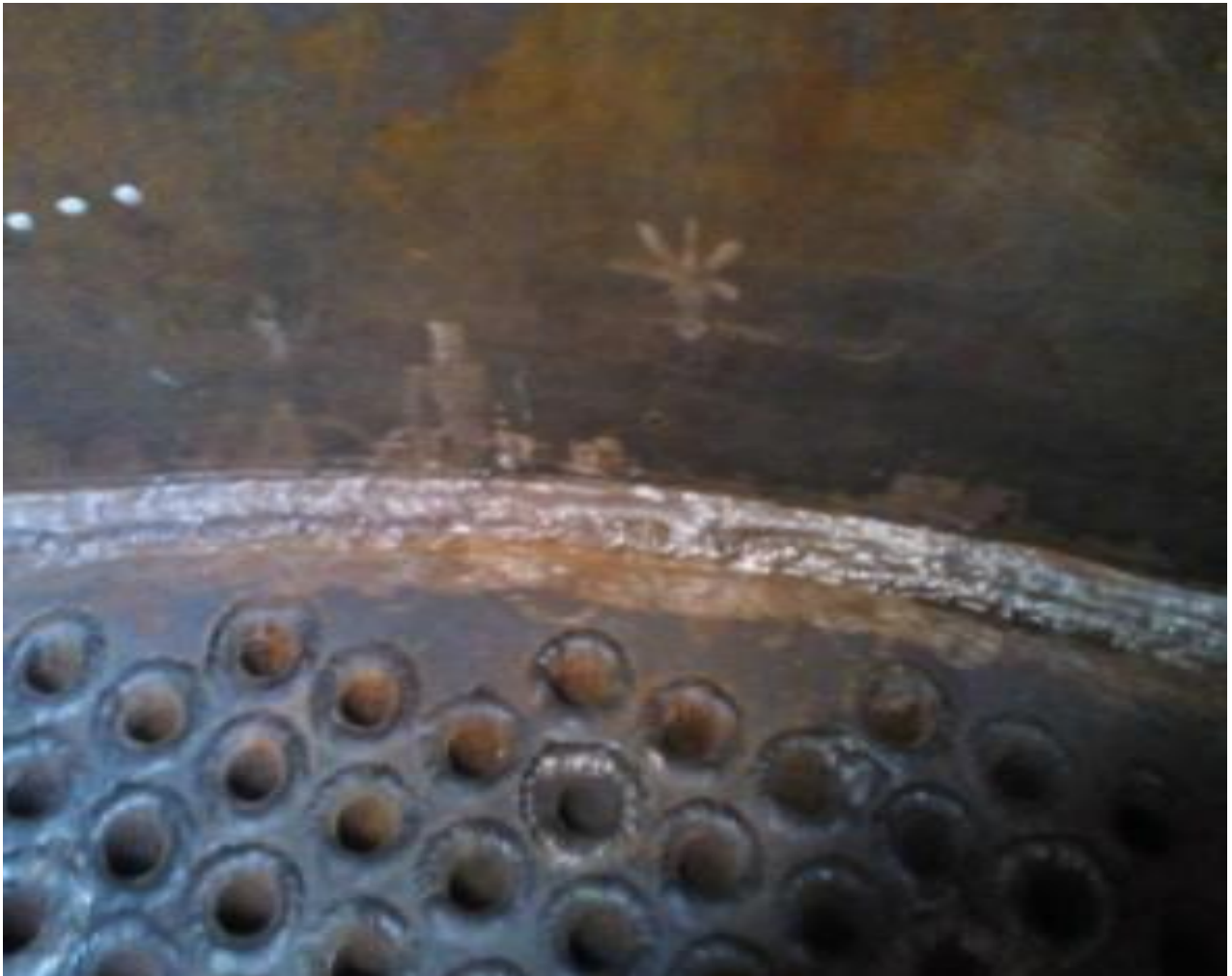
Fig2-22 : La nouvelle soudure de plaque tubulaire supérieure avec la virole et aussi avec certains tubes après réparation.[9]
