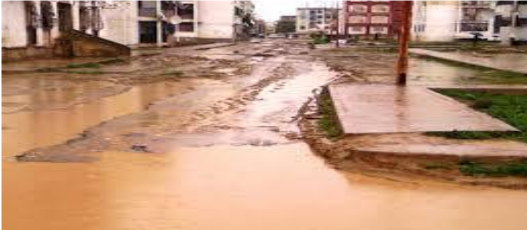
Fig.I.4. Surfaces inondées après débordement de réseau d'eau pluvial
