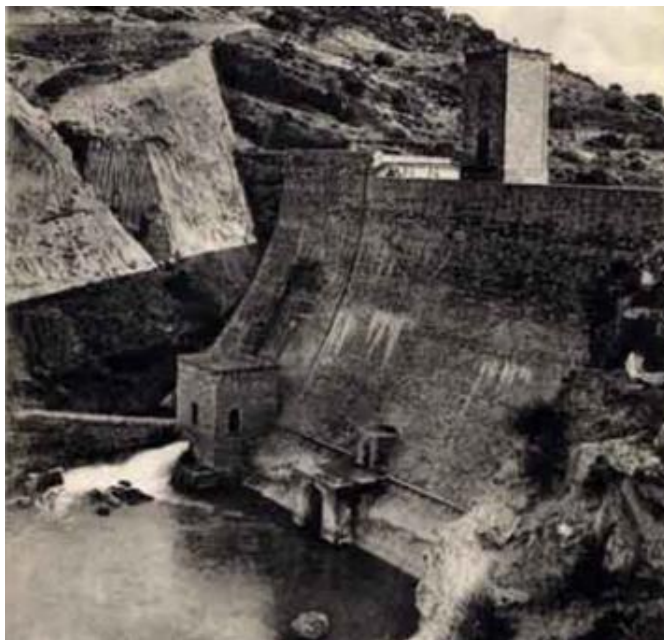
Figure 1.12 : Barrage de Cheurfas, après travaux : nouvel appui RD vers l'amont ( http://sigoise.free.fr )
