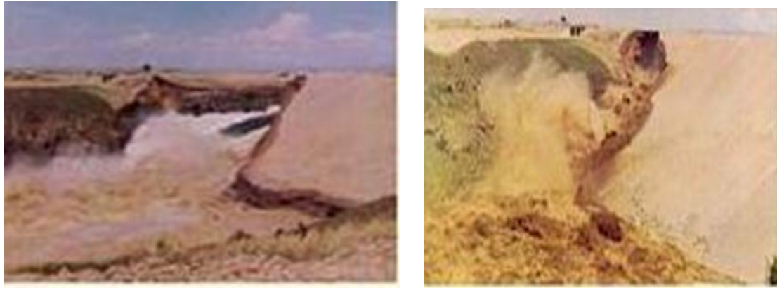
Figure 1.2 : Rupture de barrage Teton (USA) {2}
