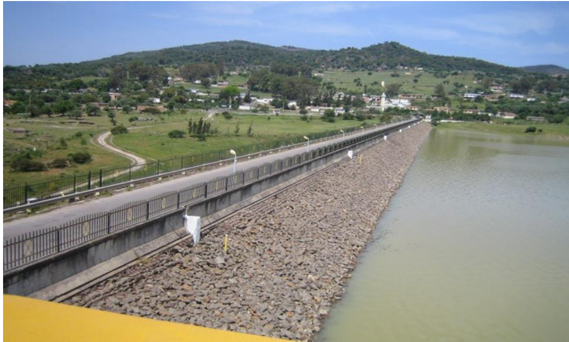
Figure 4.1 : Barrage vue générale Chaffia
