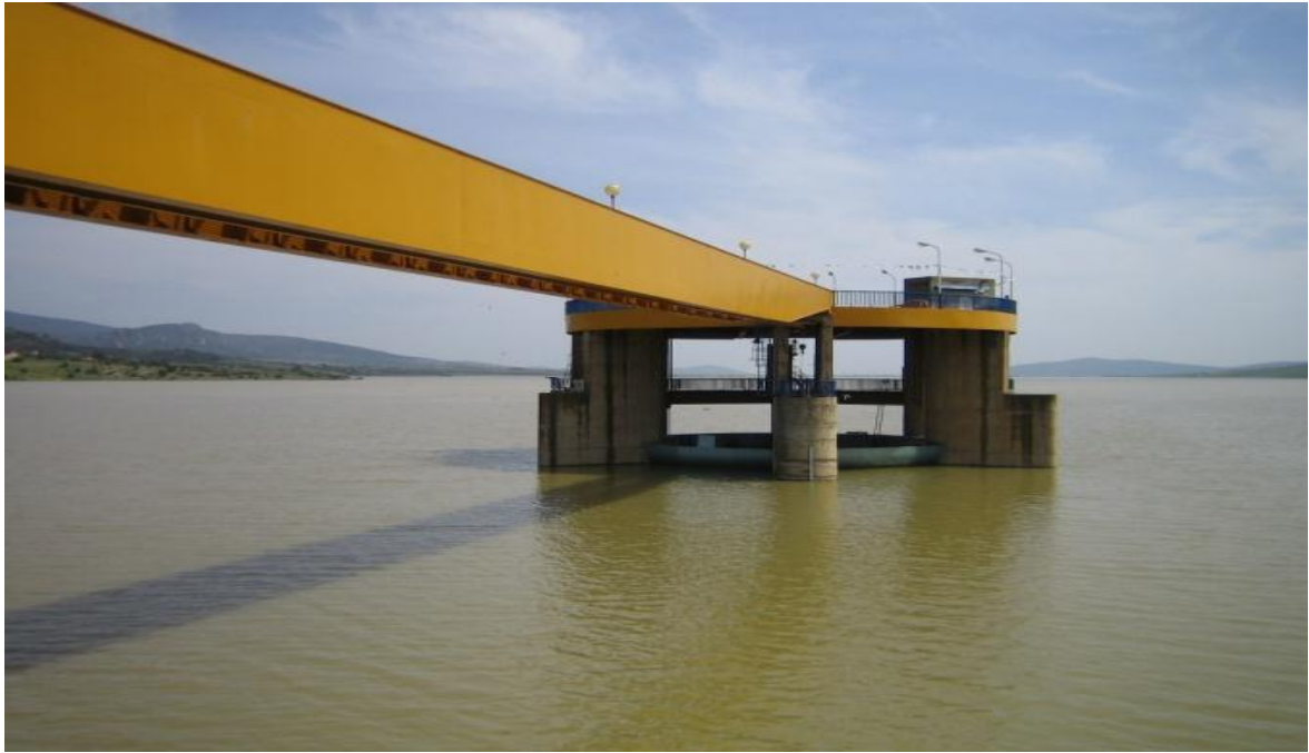
Figure 4.2: Evacuateur de crues
