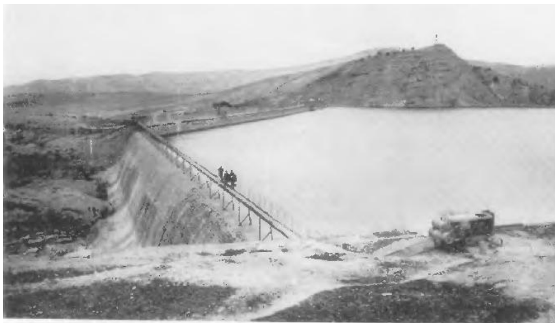
Figure 1.10 : Barrage de l'Oued Fergoug avant de rupture 25 Novembre 1927
