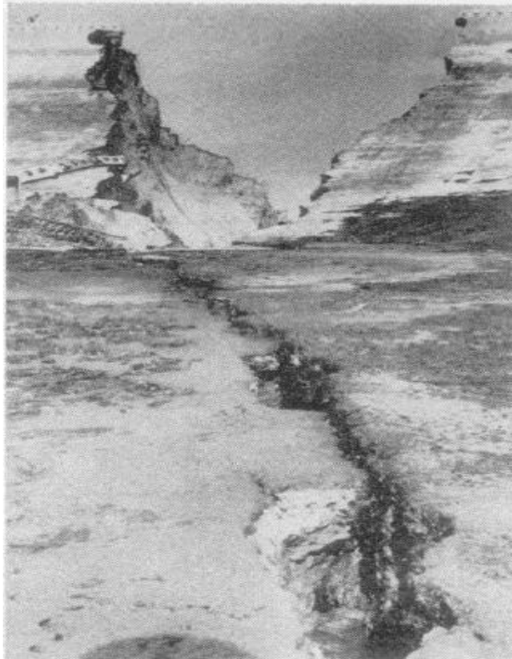
Figure 1.4 : Barrage de barrage de Baldwin Hills enfoncé. {5}
