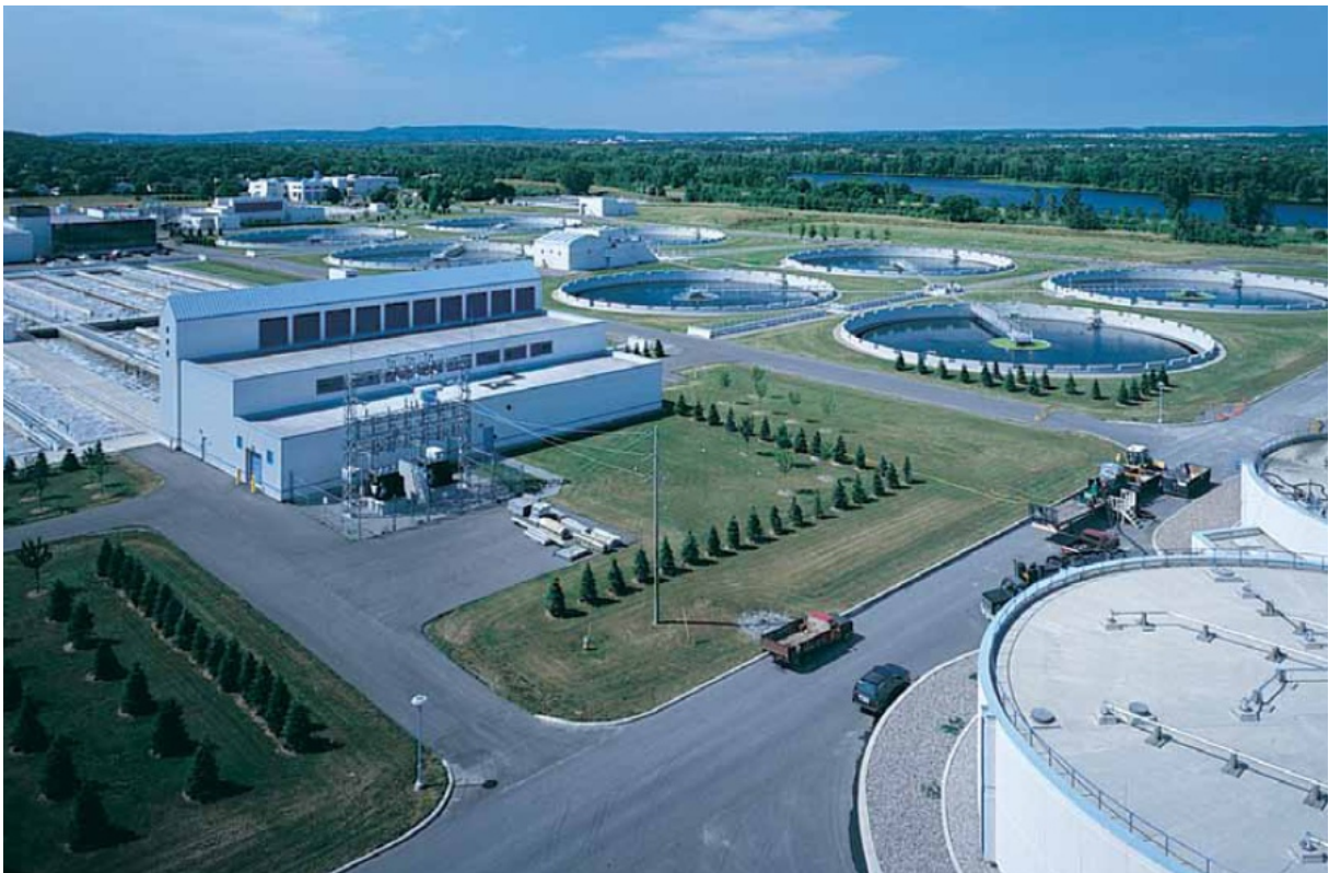
Figure.13 : photo d'une station de traitement
