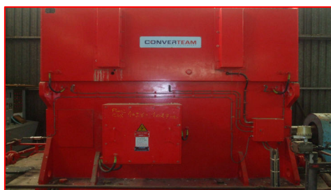
Figure I.03 : Moteur électrique Asynchrone à cage.
