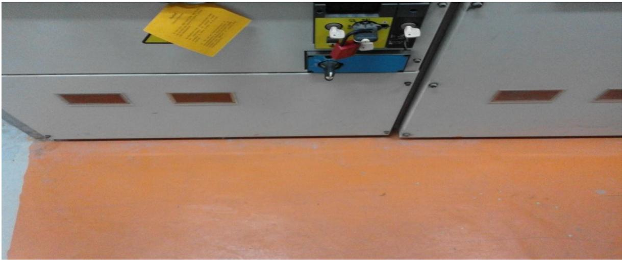
Figure IV.22 : le tapis isolant d'une salle électrique
