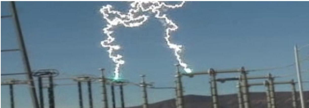
**Figure IV.2 :** arc électrique au niveau de poste
