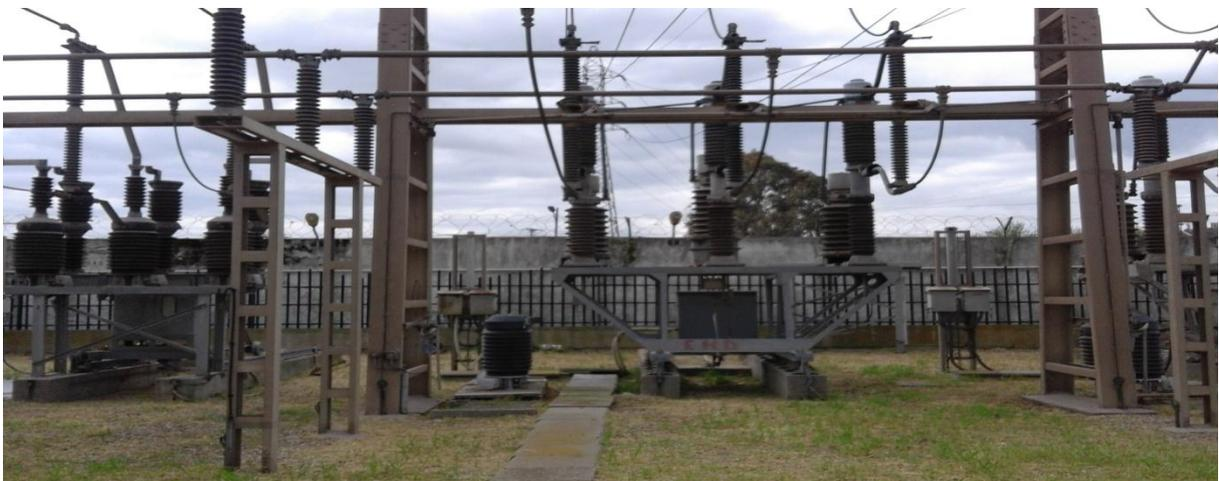
**Figure I.8 :** deux transformateur pour l'alimentation 10 MVA
