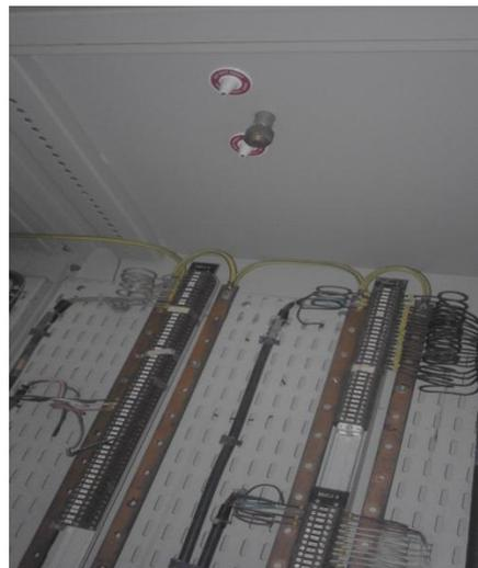
Figure IV.7: Agent extincteur co2 avec détecteur ionique de fumée
