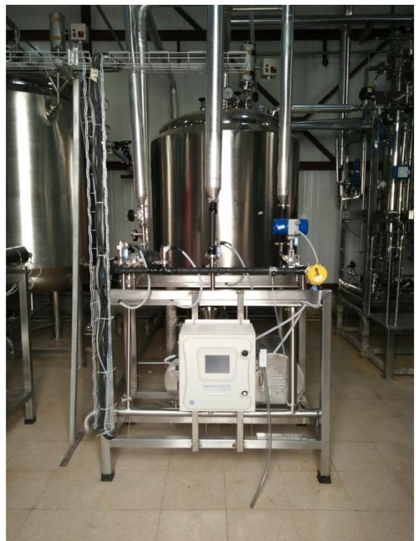
**Figure 15** - Cuve de stockage et boucle de circulation de l'EP et l'EPPI
