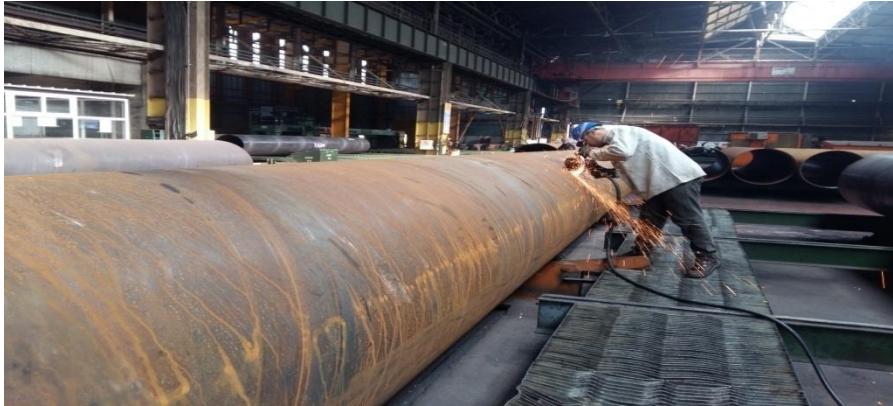
FigureI.4 : réparation des défauts manuellement
