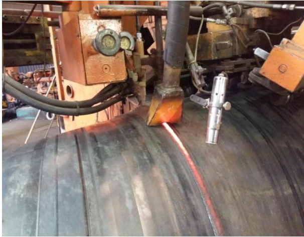
Figure I.9: soudage extérieur de tube
