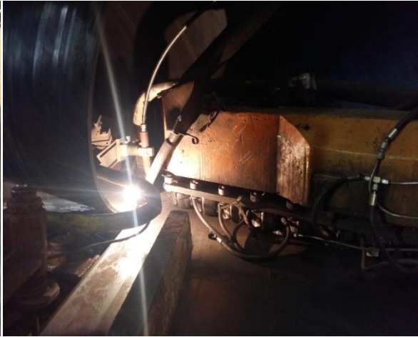
Figure I.10: soudage intérieur de tube
