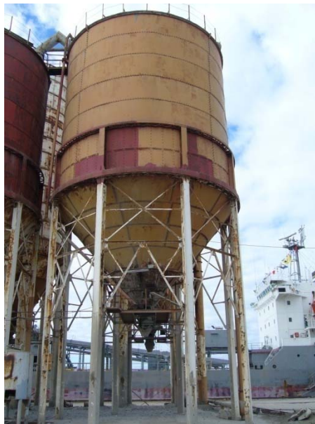
Fig.3.23 : image reel du silo testé
