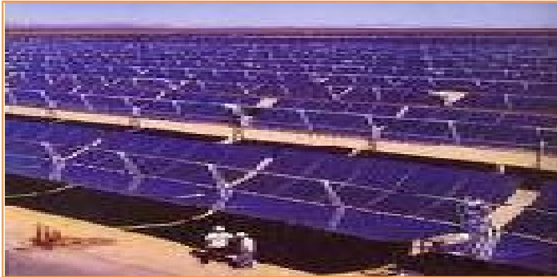
Figure 04 La centrale SEGS (Californie)
