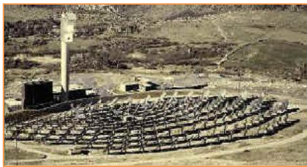
Figure 03 La centrale à tour Thémis (France)
