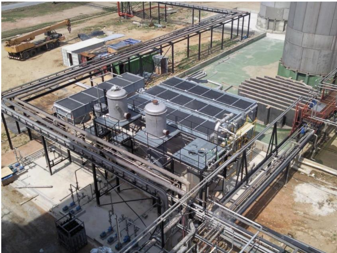
Mise en réalisation de l'unité RDC
