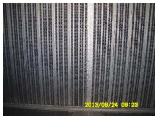
Fig. II.8 : Echangeur à plaques brasées (Prise de vue des plaques de l'échangeur)
