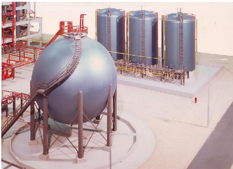
Fig.I.7. stockage de l'ammoniac liquide et de l'acide nitrique
