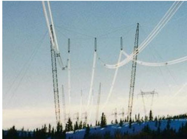
**Fig8 : I-2.2 : Pylône électrique à chaînette**
