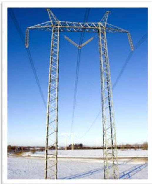
**Fig5 : I-2.1: Pylône électrique portique**
