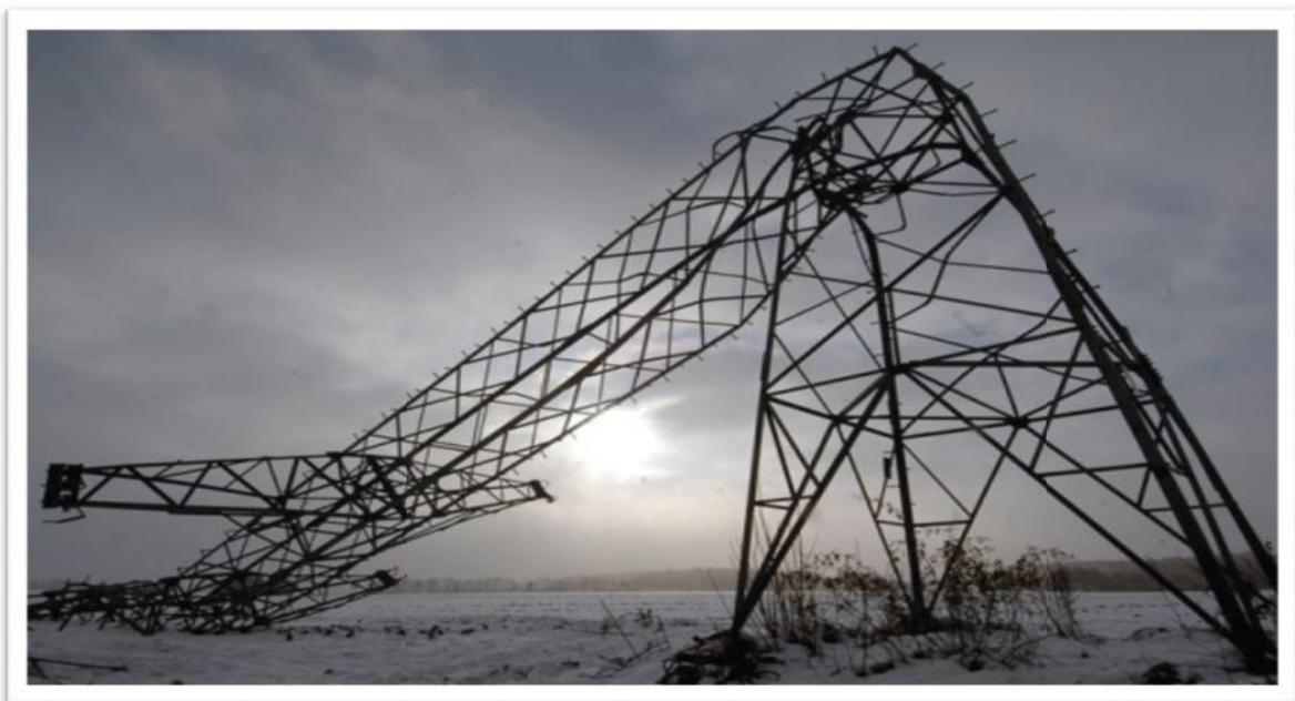
**Fig19 : II-3 : Ruine d'un pylône sous Le poids de la glace accumulé sur les lignes de transmission**
