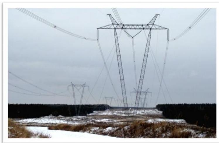
**Fig7 : I-2.2 : Pylône électrique haubané en V**
