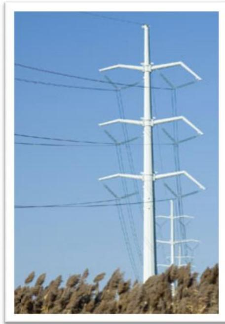
**Fig10 : I-2.3 : Pylône électrique Muguet**
