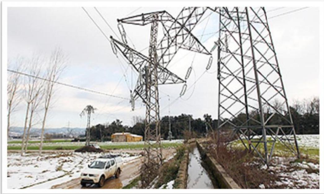
**Fig18 : II-3 : Un pylône électrique endommagé par une grande plastification /flambement a cause d'un tempête –ruine**
