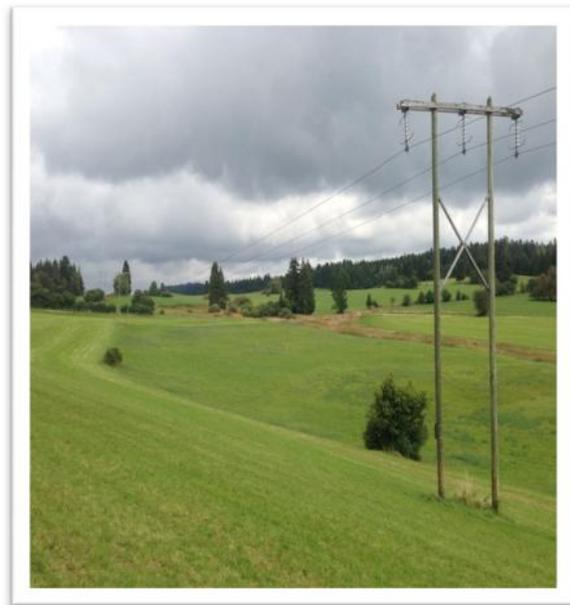
**Fig6 : I-2.1 : Pylône électrique portique**
