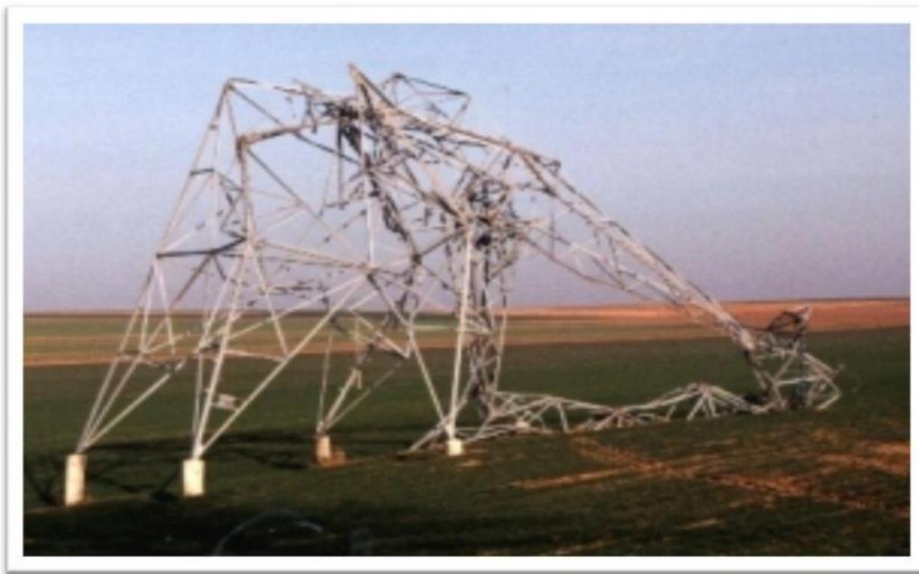
**Fig17 : II-3 : Pylônes t complètement tordus suite à la plastification totale de ses éléments causée par une tempête**
