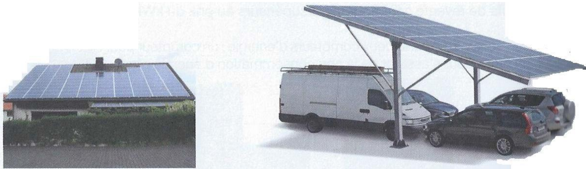
Toit solaire particulier
