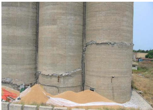
(b) Les cellules en béton endommagées des silos de grains de la société Eriad de Corso
