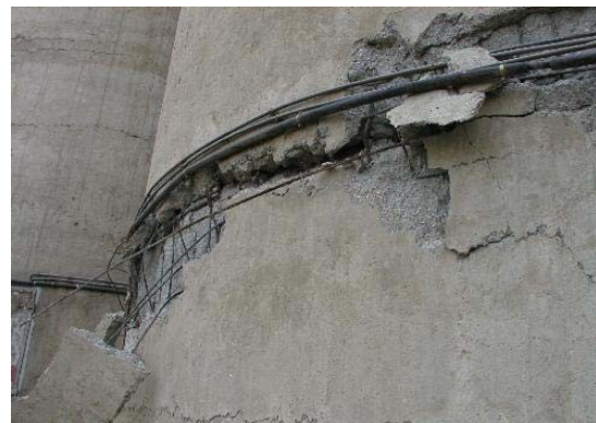
(b) Les cellules en béton endommagées des silos de grains de la société Eriad de Corso
