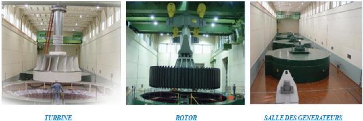
**Fig. 1.3 Quelques organes d'une centrale hydraulique [2].**
