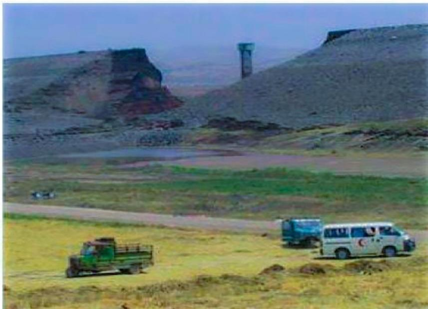
**Figure1.15 :** rupture de barrage en remblai de Zeyzoun (Syrie) [53]
