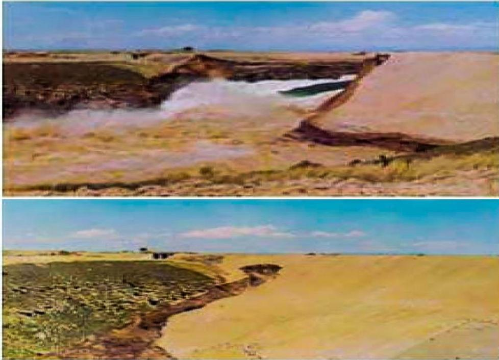
**Figure1.13** : rupture de barrage Teton (USA) [53]
