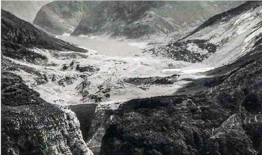
**Figure 1.11:** Barrage du Vajont après le mouvement de terrain du 9 octobre 1963. [12]
