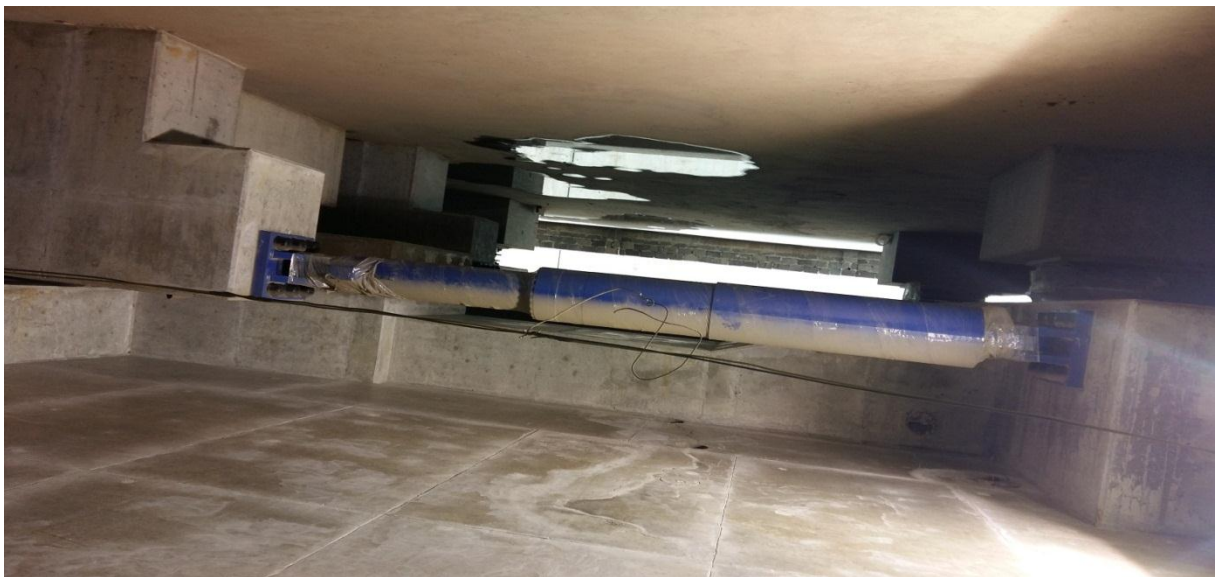
Figure II-d-1 : amortisseur visqueux – construction réalisée sur chantier
