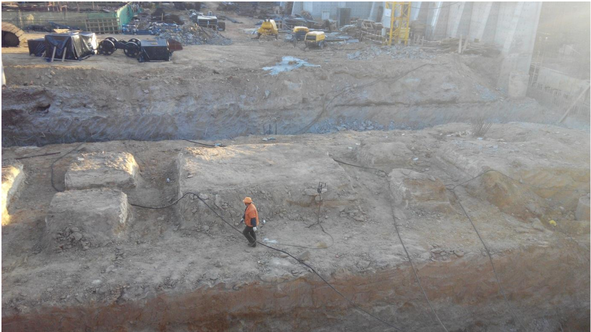
Figure VII-1 : réalisation des fondations – exemple pratique
