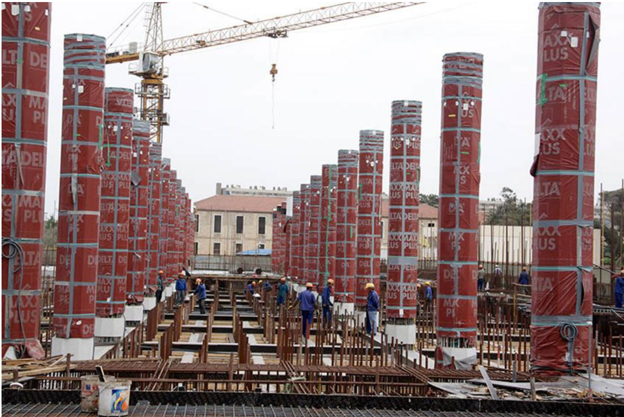
Figure VI-2-4 : poteaux déjà implantés sur chantier – exemple pratique
