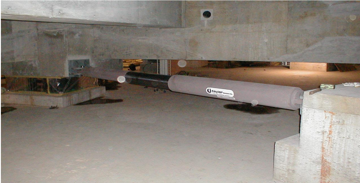
Figure II-e-5 : exemple d'application sur chantier
