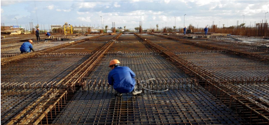
Figure VII-3 : ferrailage du radier et semelle – exemple pratique
