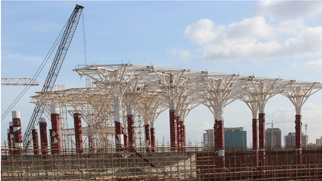
Figure VI-2-1-5: structure complète des poteaux sur chantier
