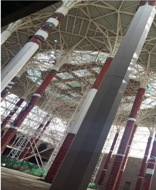
Figure VIII-2-4: structure porteuse de la coupole – vue sur chantier de l'intérieure
