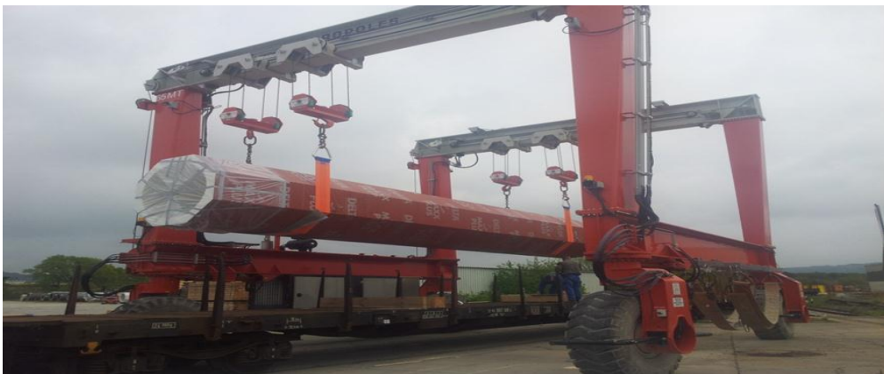
Figure VI-2-3 : transport des poteaux vers le chantier – exemple pratique
