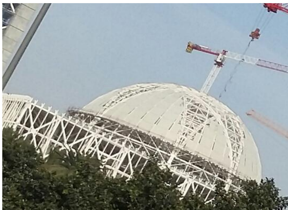
Figure VIII-2-3 : coupole – vue sur chantier de l'extérieure
