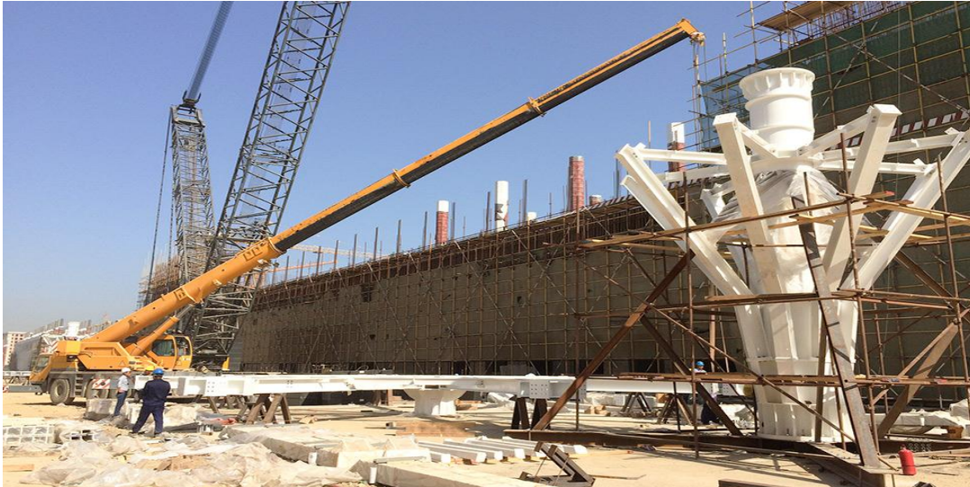
Figure VI-2-1-3 : chapiteau déjà prêt à l'agencement avec les poteaux
