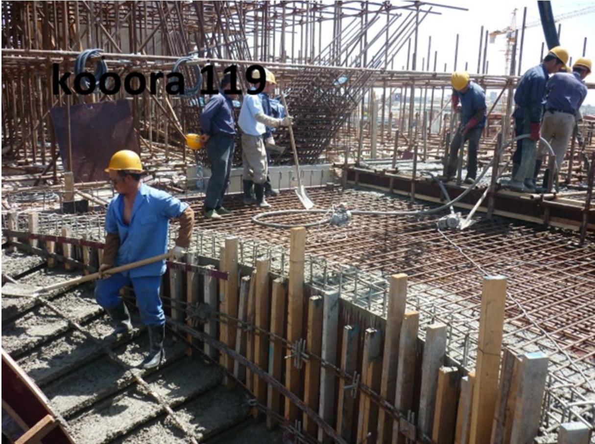
Figure IX-1 : coulage du béton sur chantier
